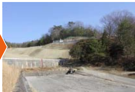
廃止措置後の状況（平成28年3月）
